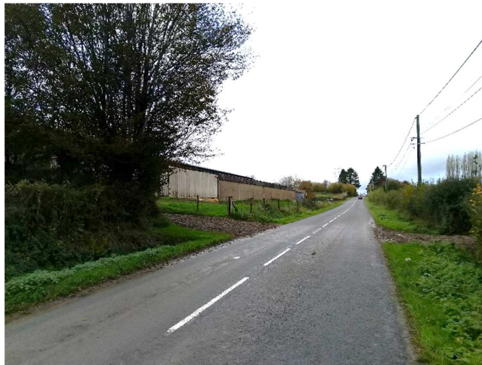
Figure 9 : Photo 2, Vue Nord-Est sur la D9364
